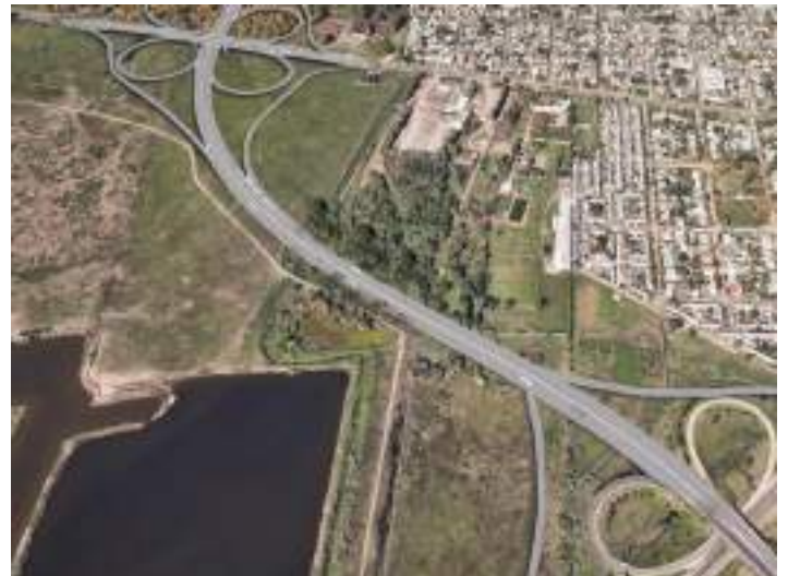
Nueva bajada de Autopista La Plata - Buenos Aires hacia Calle 128
